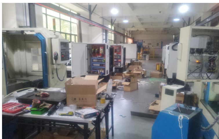
图1 数控系统升级改造现场情况
